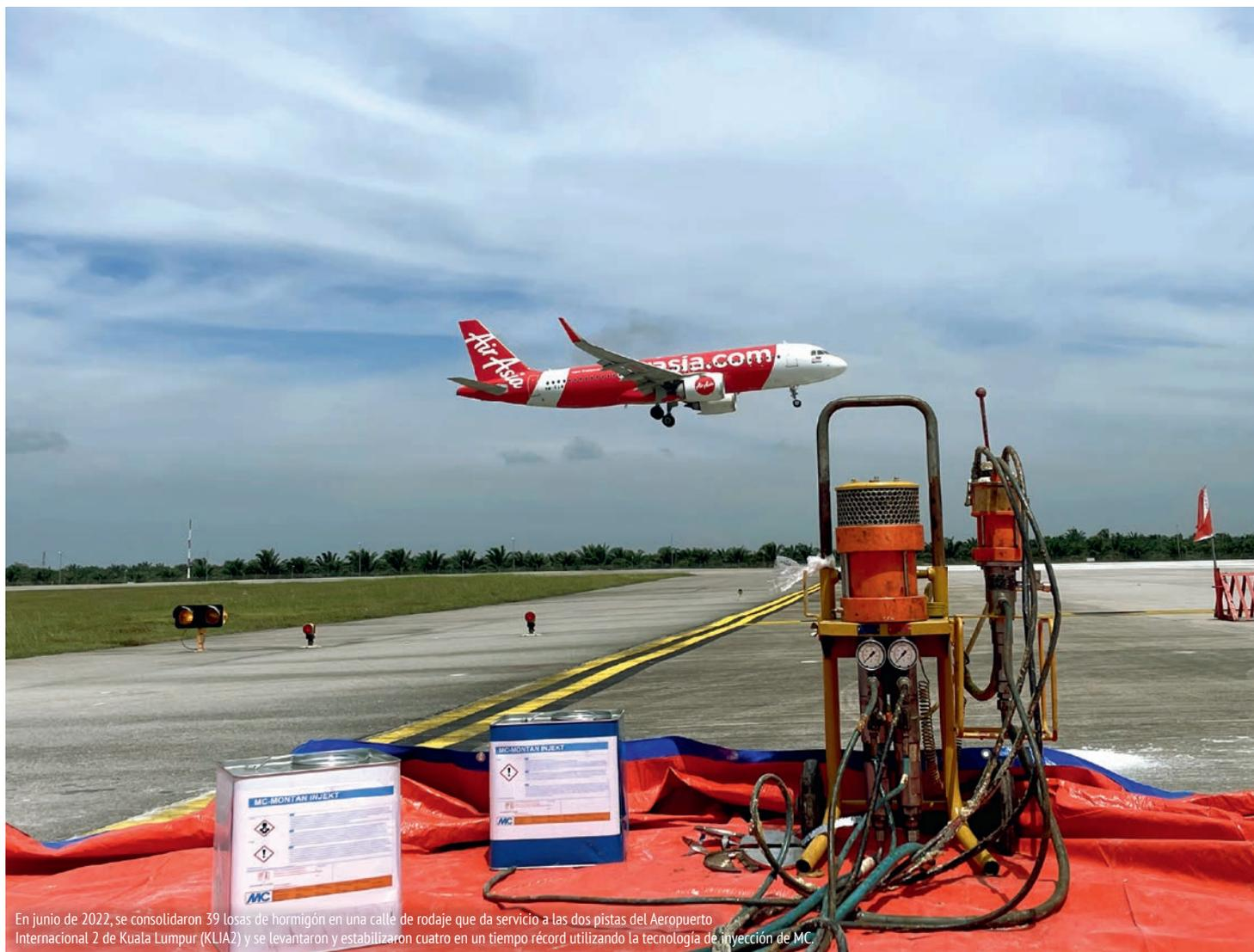
En junio de 2022, se consolidaron 39 losas de hormigón en una calle de rodaje que da servicio a las dos pistas del Aeropuerto Internacional 2 de Kuala Lumpur (KLIA2) y se levantaron y estabilizaron cuatro en un tiempo récord utilizando la tecnología de inyección de MC.
